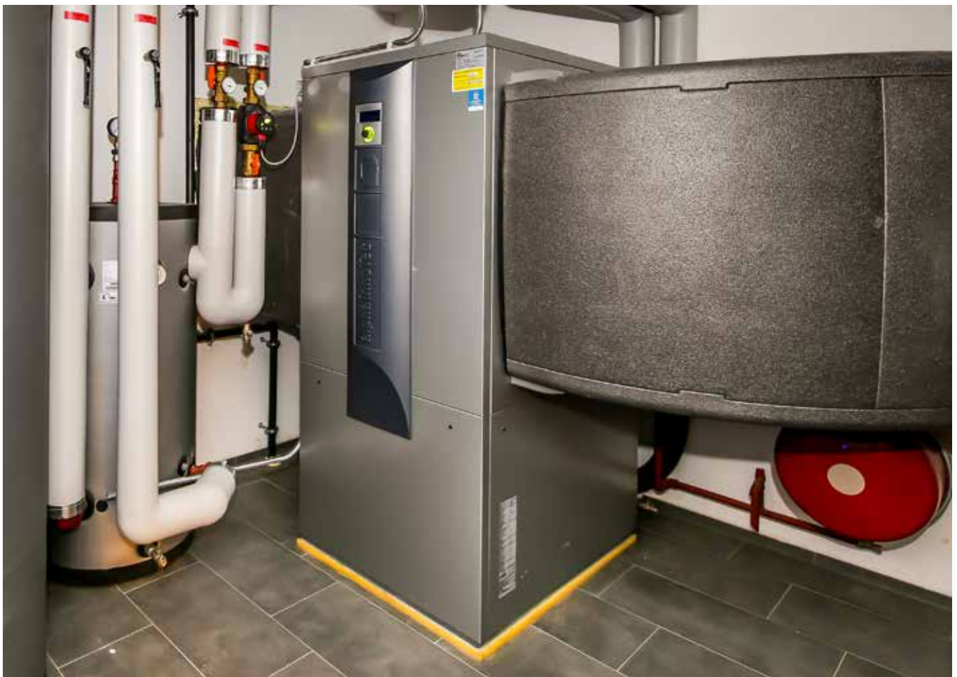
alira LW 160H/V mit frequenzgeregeltem Verdichter und Luftkanalsystem LKS 900
