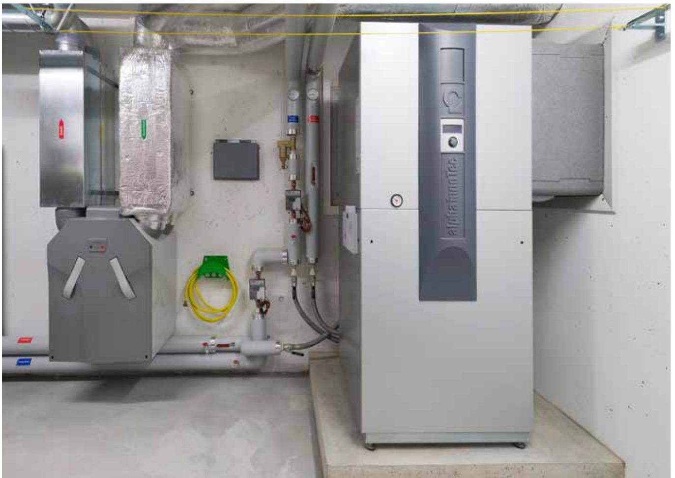
alira LWC mit Luftkanalsystem LKS 700
