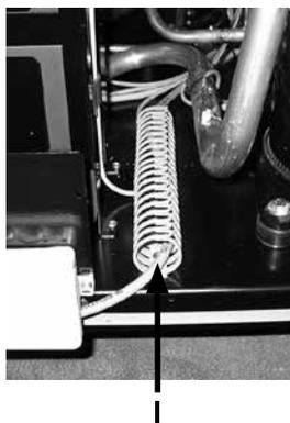
I Kabelkanal für Steuer- und Fühlerleitungen (nur bei LW 140A/RX)
