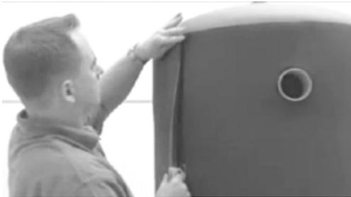
6. Zweites Klebeband über den Stoß des Isoliermantels kleben.
