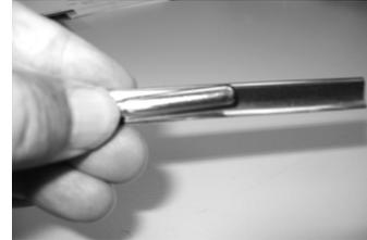
1. Fühler an Außenseite der Fühlerfeder anlegen.
