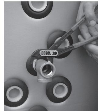
3. Das Gewinde des flexiblen Wellrohres aufdichten und in das T-Stück einschrauben.
