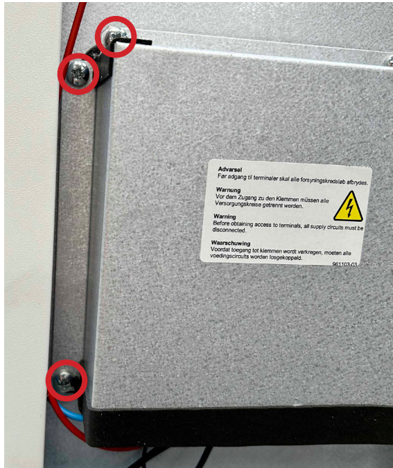
Rimuovere le 3 viti della copertura protettiva mostrate nell’immagine.
