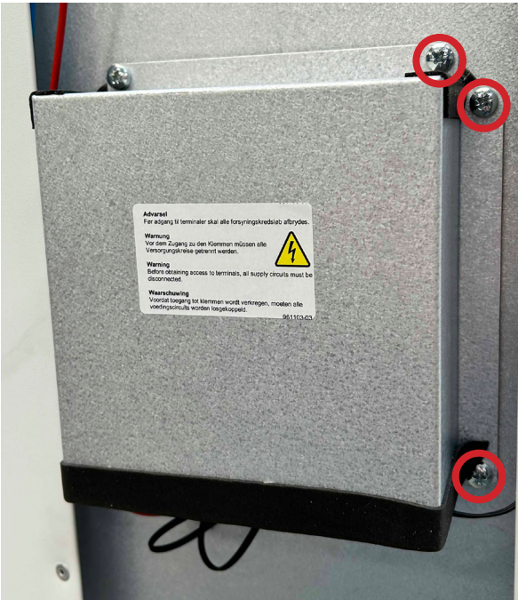
Rimuovere le 3 viti sul lato destro della copertura protettiva mostrate nell’immagine.
