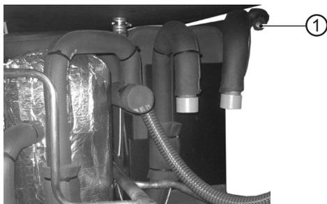
1 Vanne de purge, au-dessus des raccords hydrauliques dans l'appareil
