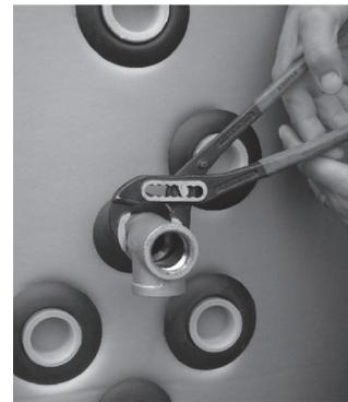
3. Étanchéifier le filetage du flexible ondulé et visser dans le T.
