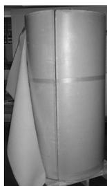
5. Retirer les deux enveloppes d'isolation et les mettre de côté.
