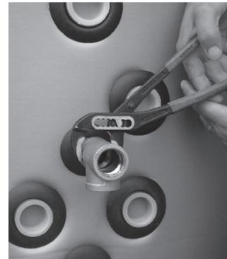
3. Togliere la guarnizione dalla filettatura del tubo ondulato flessibile e avvitare la filettatura nel raccordo a T.
