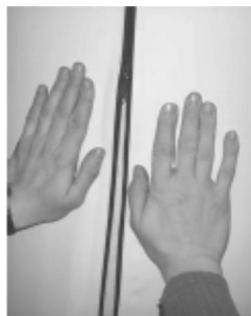
1. PVC Mantel um den Speicher legen und vorsichtig mit dem Reissverschluss schliessen. Gegebenenfalls kann durch leichtes Klopfen mit der flachen Hand nachgeholfen werden.
