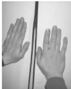
8. Placez la gaine en PVC autour du réservoir de stockage et fermez-la soigneusement avec la fermeture éclair. Si nécessaire, vous pouvez vous aider en tapotant légèrement avec la paume de votre main.
