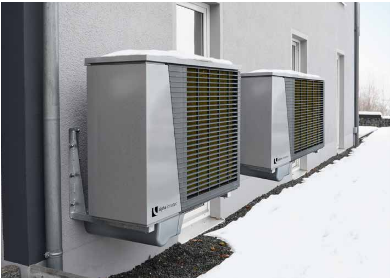
LWD-Twin: fonctionne avec 1 ou 2 compresseurs
